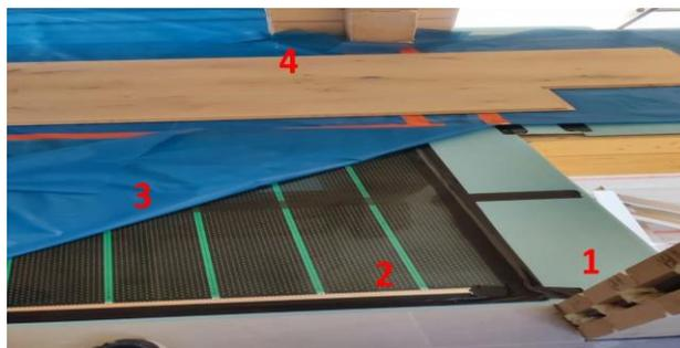
1. Unterlage – mindestens 4 mm dick, gut isolierend - normalerweise aus XPS; die Unterlage sollte dick genug sein, um Anschlüsse und Leitungen darin zu verlegen; 2. Heizfolie; 3. Dampfsperrfolie; 4. dreischichtige Diele von Barlinek;
